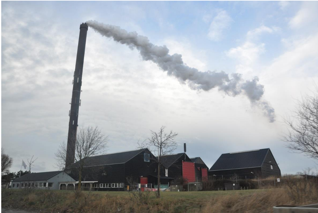
Figur 10. Stålvalseværket i Frederiksværk.
