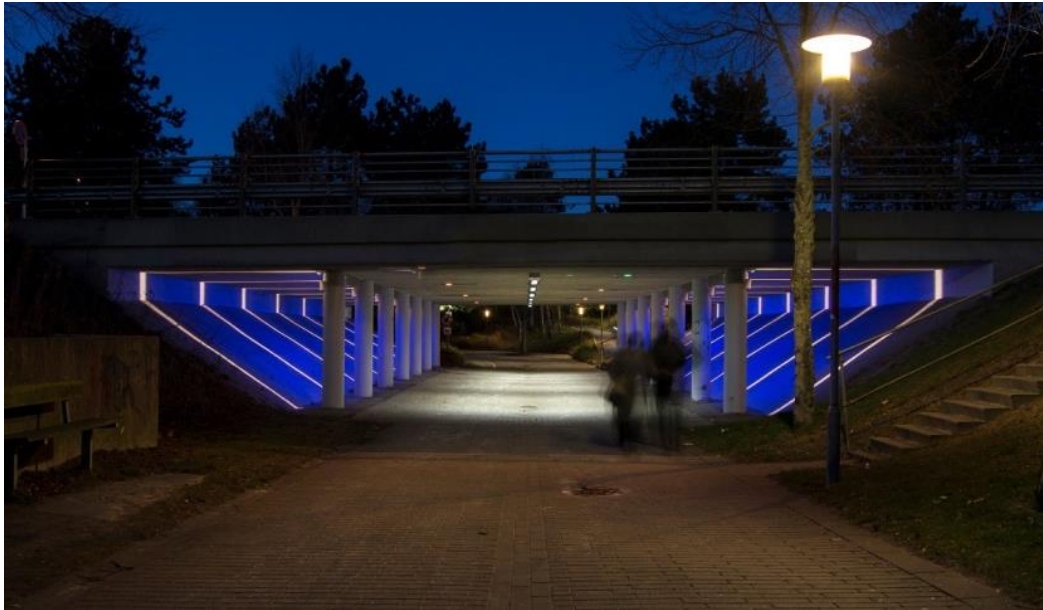
Figur 50. Karakterskabende stitunnelbelysning ved Farum Bytorv.
